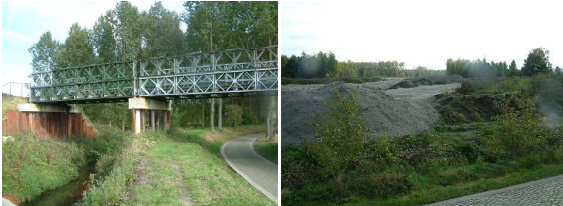
Pont pour le transport de terre construit au-dessus de la "Barbierbeek" et la digue de ceinture en construction.
