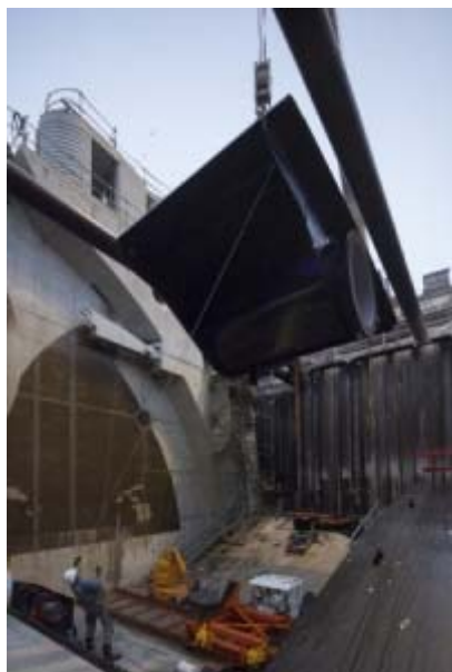
Pose du clapet
