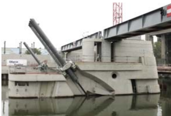
Pile du barrage
